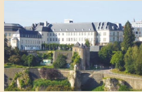
2017: un édifice au fil du temps (XVI e -XXI e s.) – ein Gebäude im Wandel der Zeit (16.-21. Jh.) – a building in changing times (16 th -21 st c.)
